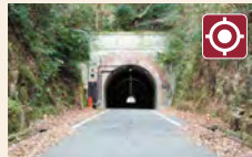
⑤ 峠清水トンネル
